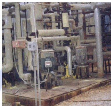
شکل (۱۰-۴) نمایی از پمپ مخصوص گوگرد مذاب
