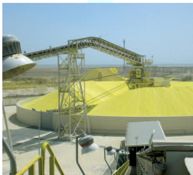
شکل (۲-۳) انبارش گوگرد به شکل دانه بندی با دیواره محافظ اطراف
